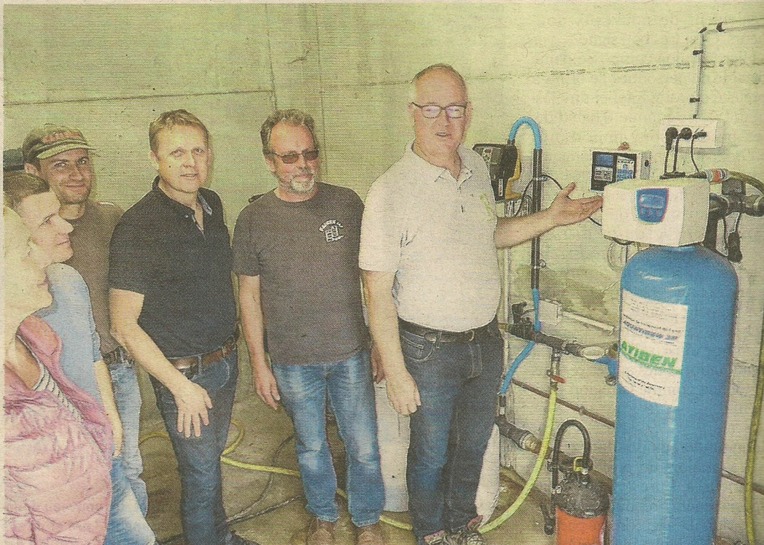
De droite à gauche, Henri de Malliard, Christophe Grosjean et Benoît Pintat dans le local de la station de traitement de l'eau. Photo A.R.
